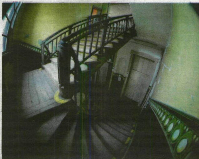
Klatki schodowe, wraz całym wnętrzem, będą odnowione
